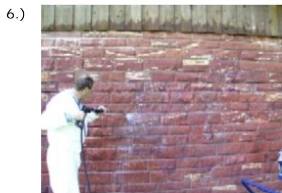
NewPro Graffitentferner für Sandstein unter Verwendung eines Spezialentferners für Graffiti (Anfertigung auf Wunsch). Für Filzstifte oder Eddingstifte wurde NewPro-GE 209 Graffitentferner verwendet. Als anschließender Schutzfilm wurde das NewPro-GS 207 Graffitischutzsystem (Opferschicht) aufgetragen.
